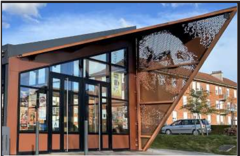
Théâtre Léo Ferré Rue du foyer, Aulnoye-Aymeries
